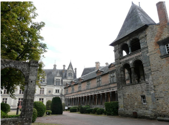
Château de Châteaubriant (Galerie sud)
