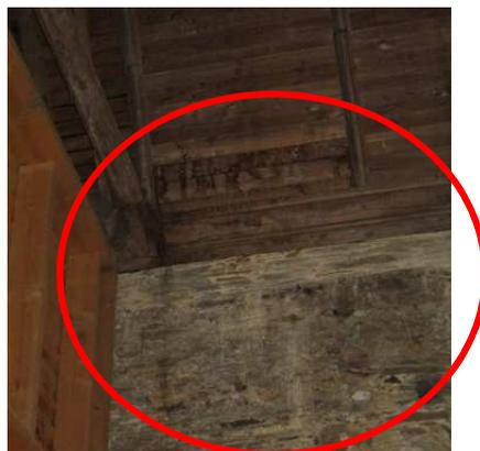
*Traces de l'infiltration sur la charpente*
